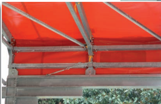
Vista della trave aerea
