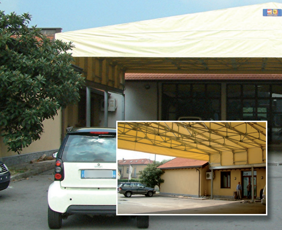
Vista frontale della copertura
